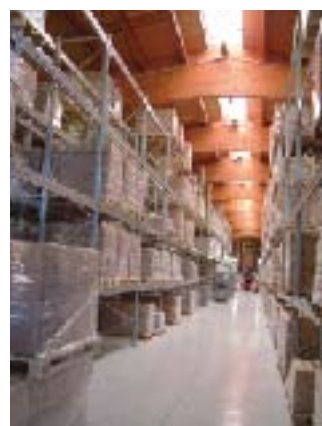
天窓から外光を取り入れている木造倉庫
