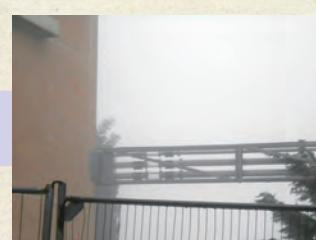
小麦粉は製粉工場からパイプの中を圧縮空気によって送られて、一時貯蔵庫に保存されます。そこからさらにパスタ工場の製造ラインへパイプで送られます。
